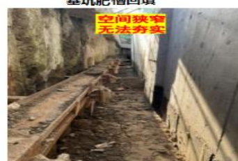
流态固化土回填
