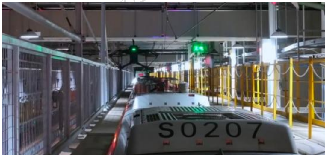
图 3 无人机车顶巡检
